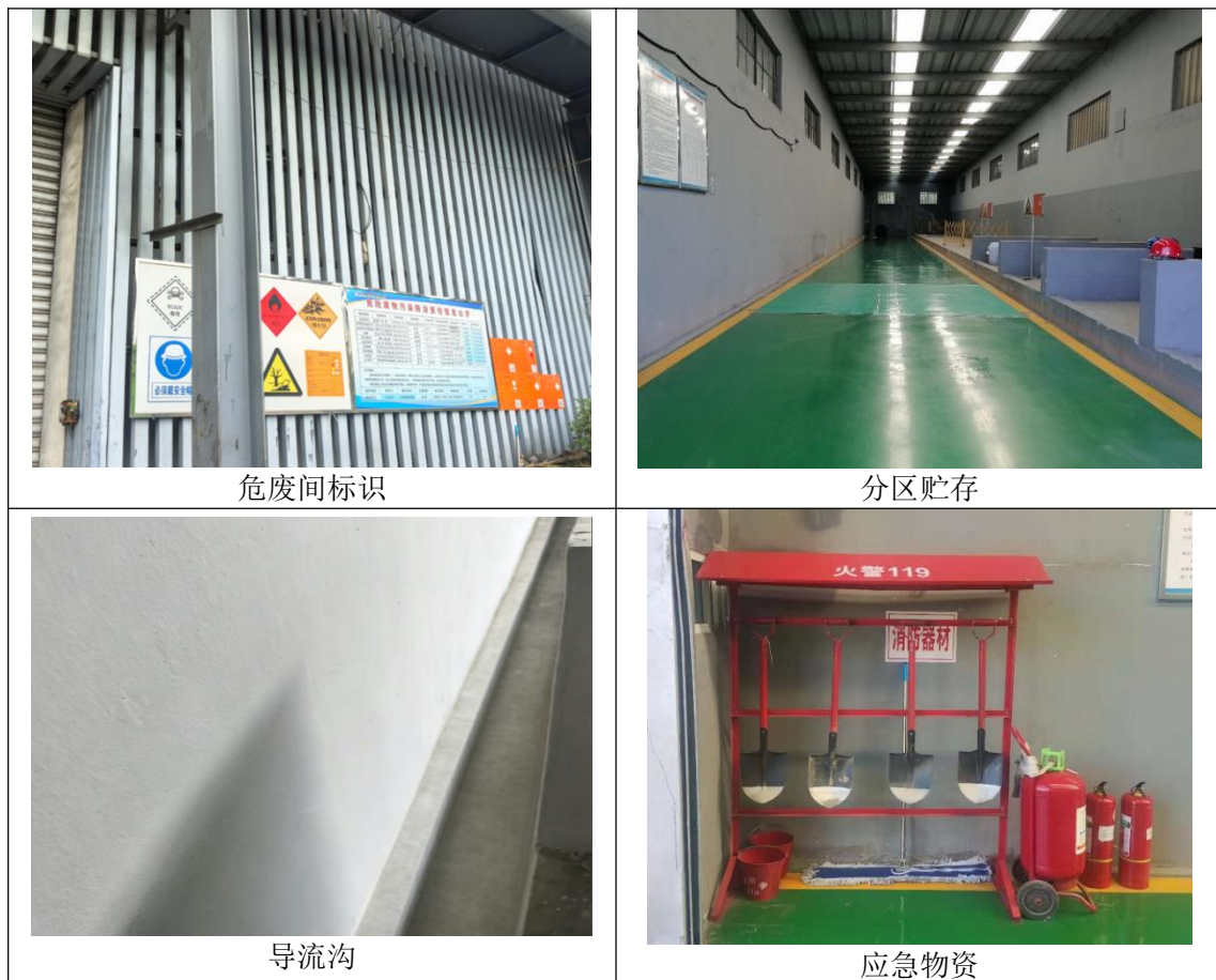
图 4.1-5 危废间现场图
